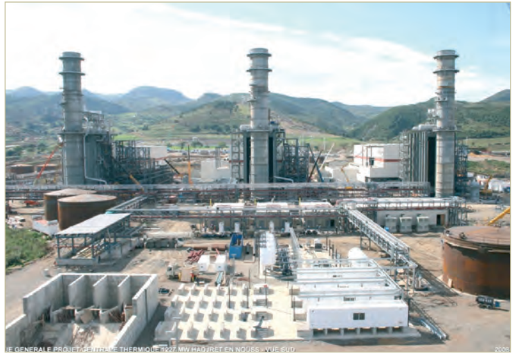
Central Térmica de Ciclo Combinado de Hadjret (Argelia), 3X400 MWe.
