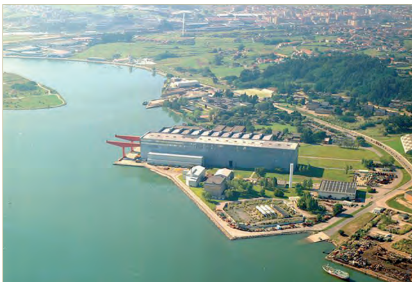
Foto 1. Fábrica de ENSA en Maliaño (Cantabria).
