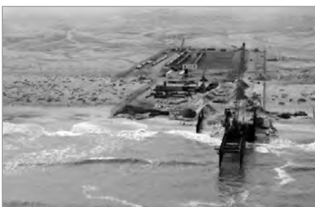
Trekkopje : Planta de desalinización.
