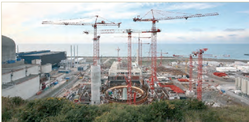
Figura 4: Emplazamiento de la obra en Francia.
