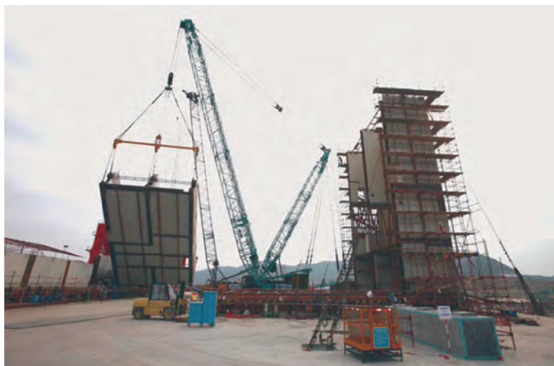
Figura 15: Izado del segundo sub-ensamblaje del módulo CA20 (1).
