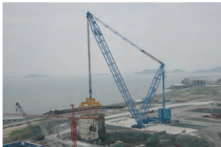
Figura 16: Colocación del CA20 en su posición final.
