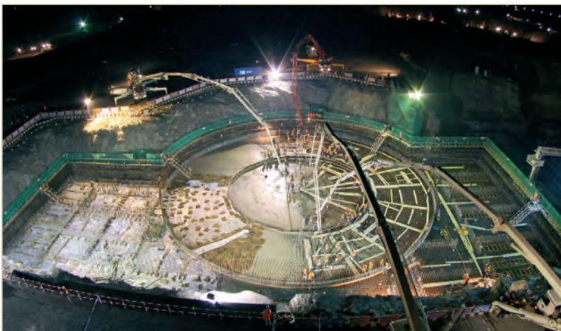
Figura 21: Hormigonado nocturno en Sanmen.
