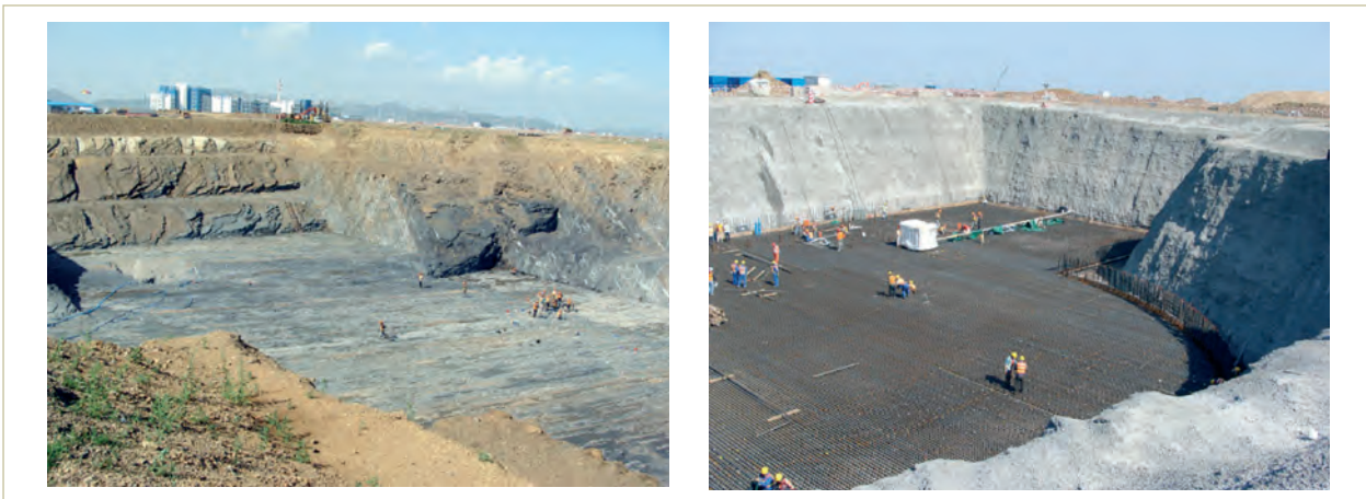
Figuras 18 y 19: Excavación y preparación de la losa.
