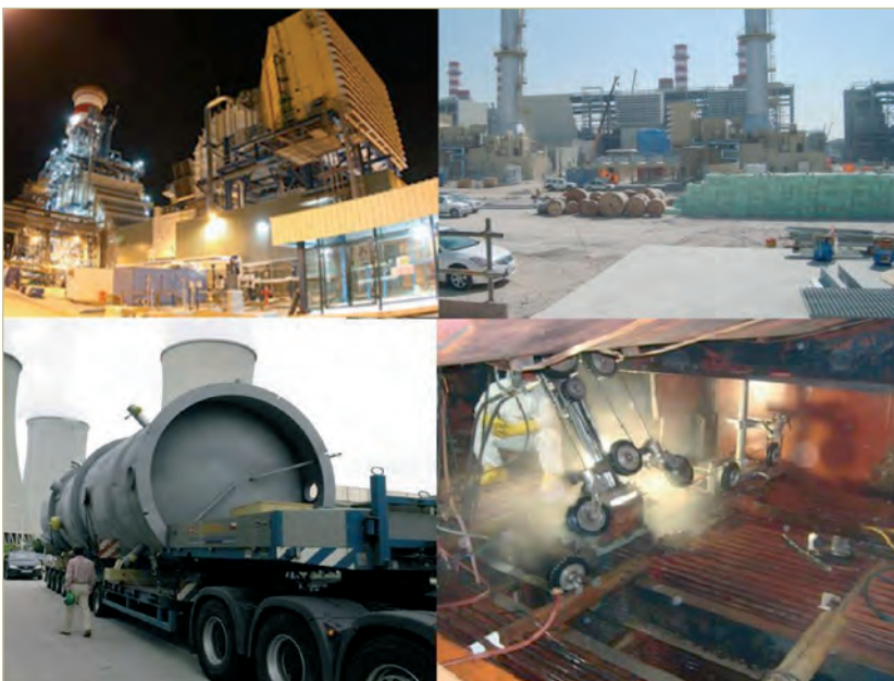
Proyectos de Ciclos combinados (arriba izq. y dcha.), sustitución de los MSR de la central eslovaca de Bohunice V2 (abajo izq.), aumento de potencia de la central mejicana de Laguna Verde (abajo dcha.)
