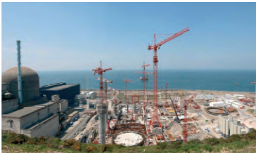
Central nuclear Flamanville 3. Detalle de las obras.
