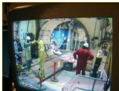
Control remoto y seguimiento de trabajos con teledosimetría en el Pozo Seco.
