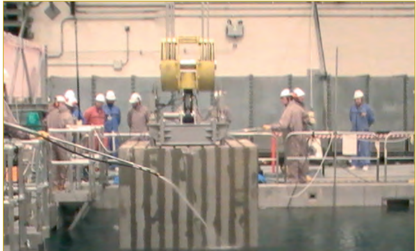
Trabajos ampliación piscina de combustible y almacenamiento de "racks" extraídos en blindaje.
