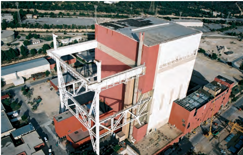
Desmantelamiento de la central nuclear Vandellòs I.
