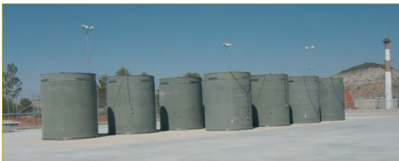
Figura 3. ATI de la central nuclear José Cabrera.
