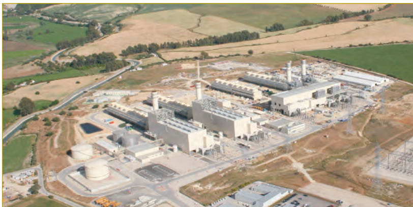
Figura 2. Central de Ciclo Combinado de Arcos de la Frontera (Iberdrola). Dos monojees y un grupo 2x1
