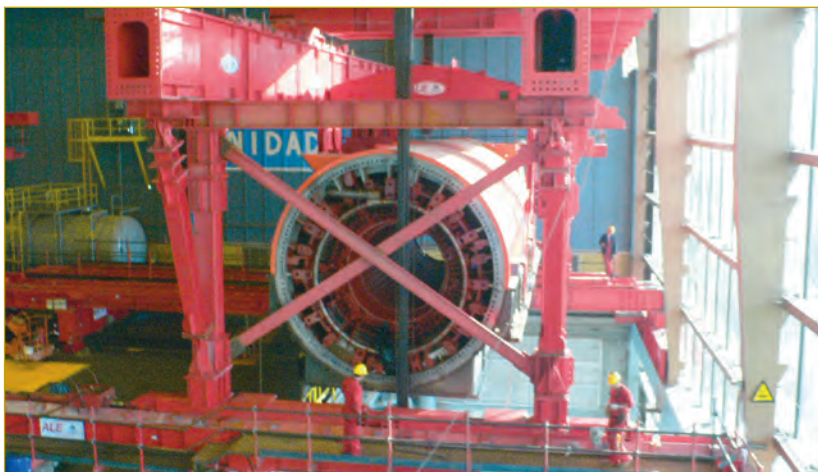
Figura 2: Maniobra de izado del Nuevo Alternador vista lateral del estator.
