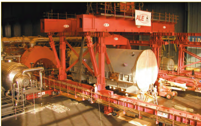
Figura 1. Maniobra de izado del Nuevo Alternador.
