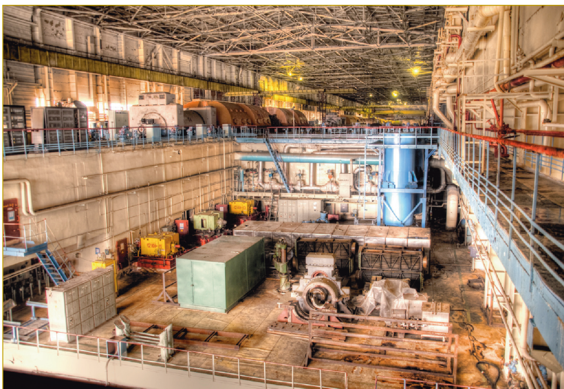
Foto 6. Edificio de turbina.
