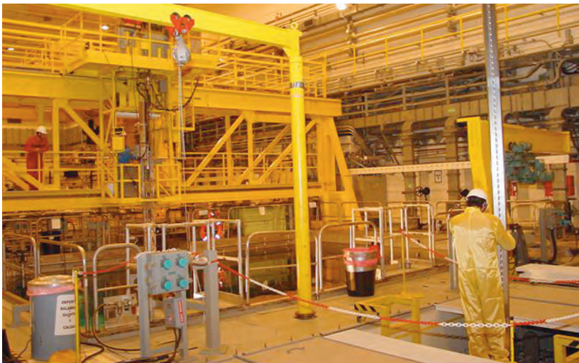
Almacenamiento de un elemento de combustible nuevo en bóveda seca.
