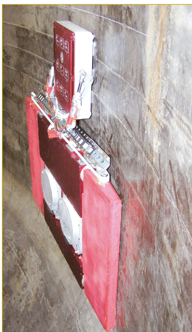
Foto del equipo Lily Pad para inspección del secador.
