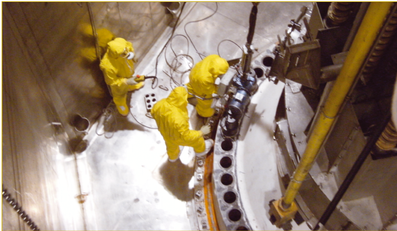
Equipo de desenroscado y roscado de pernos de vasija.
