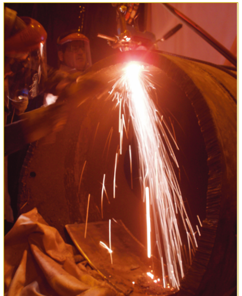
Figura 5. Detalle del corte del Cross Under.
