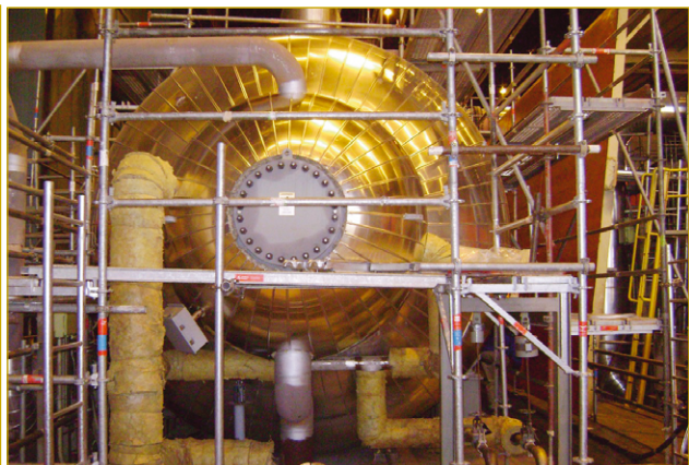
Figura 11. Detalle de montaje de aislamiento.
