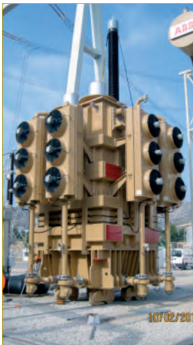
Figura 3: Sustitución transformadores principales en C.N.Vandellós II.
