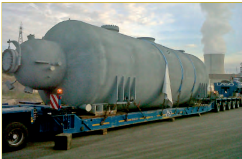
Figura 4: Nuevos MSR pendientes de instalar en C.N.Ascó.
