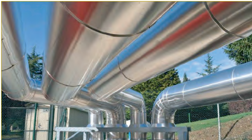
Figura 3: Tuberías de LPCI y de PCI.
