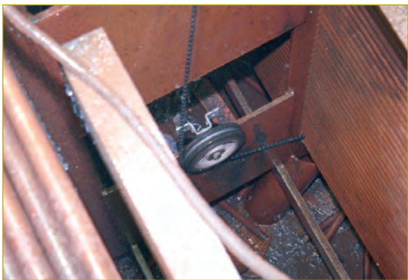
Figura 14: Corte con hilo de diamante.
