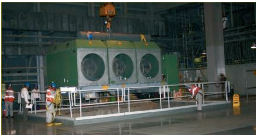
Figura 11: Instalación del nuevo Interruptor de generación.
