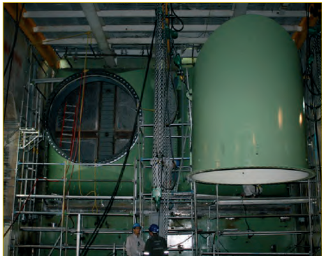
Figura 6. Introducción nuevos haces tubulares en el condensador.
