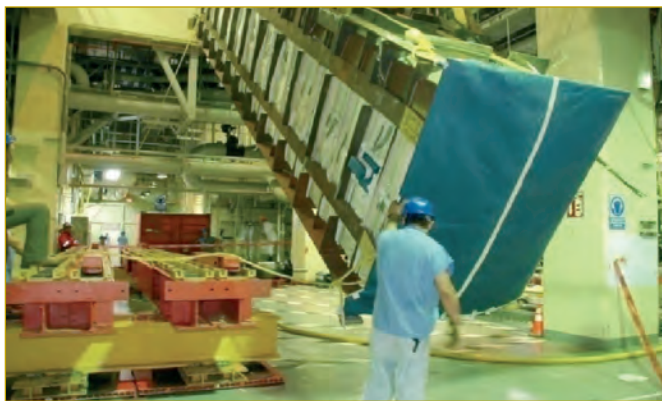
Figura 15: Volteo de haces mediante sistema hidráulico.
