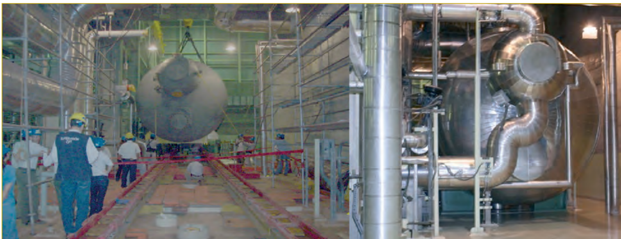
Figura 3: Maniobra instalación nuevo MSR.
