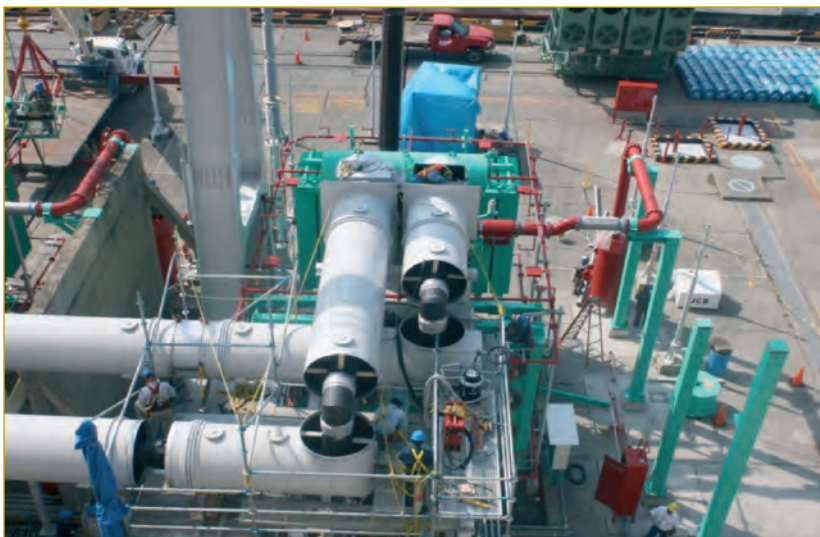
Figura 10: Alineación y soldadura de tramos externos de las nuevas barras de fase aislada.
