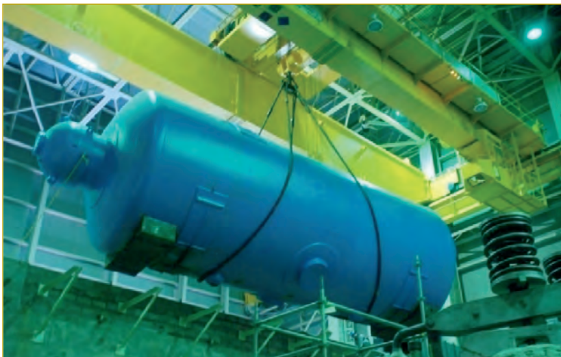
Figura 2. Maniobra extracción MSR con nueva grúa ed. de turbina.
