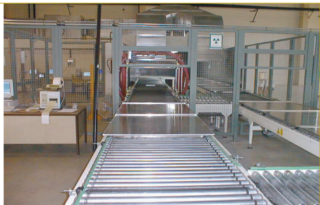
ZONA DE CARGA
