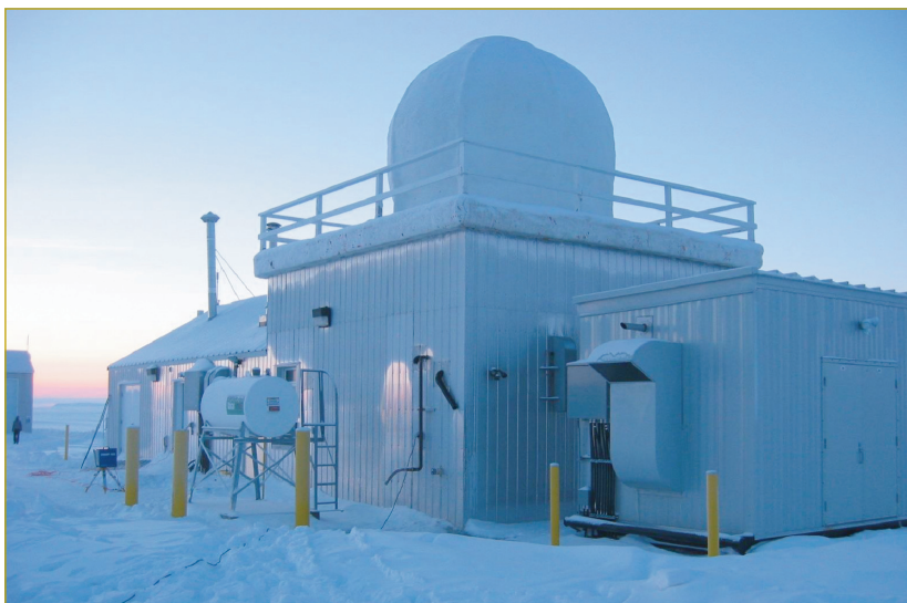
Estación de medida de radionucleidos del sistema de verificación del CTBTO.
