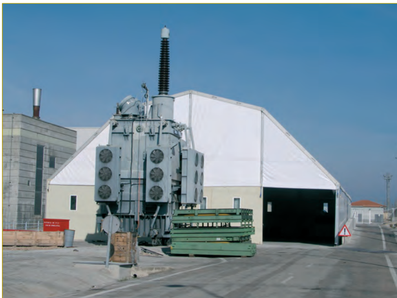
Renovación transformadores principales.
