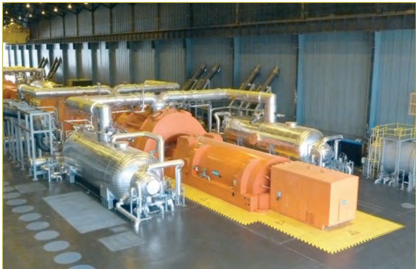
Cambio de separadores y recalentadores de vapor.
