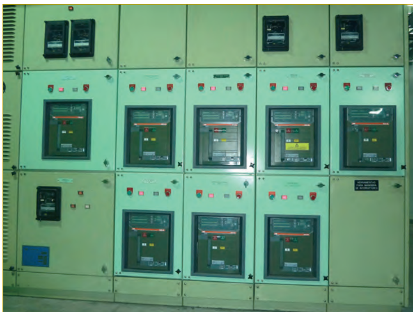
Sustitución de los interruptores de 380V.
