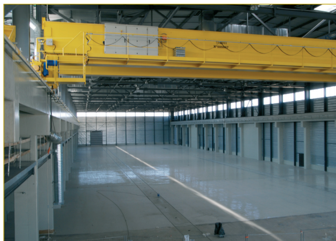
Figura 11. Vista de la nave principal del PF coil. Con su nave principal exenta para la instalación de las salas de devanado y pruebas, el PF coil es uno de los edificios más grandes de la instalación. Se aprecia el puente grúa en primer término y la tipología estructural mixta consistente en estructura principal de hormigón armado y cerchas de acero. Foto Septiembre 2011, cortesía F4E.
