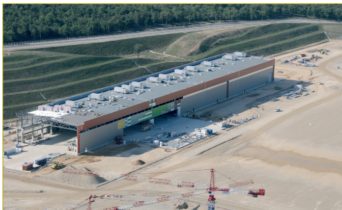
Figura 8. Vista aérea del PF coil. Se observan sobre el lateral del edificio más cercano al observador las puertas de 30m cada una para dar salida a las bobinas poloidales de 24m y la solera de la zona de pruebas. Septiembre 2011. Foto, cortesía IO.
