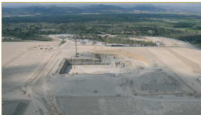
Figura 12. Vista aérea de la excavación del Tokamak. Foto abril 2011, cortesía Spie/Batignoles.
