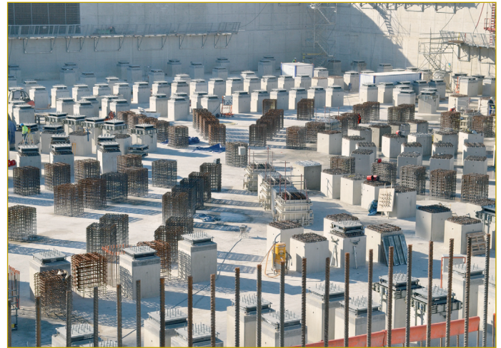
Figura 19. Detalle de la zona central del pozo del Tokamak. Esta foto es representativa de las distintas fases de ejecución de los plintos de los disipadores sísmicos. A la izquierda, armaduras de los plintos en espera, hacia el fondo, plintos con los disipadores ya instalados. Y hacia el centro, plintos con armadura en espera de hormigonado de segunda fase. Foto enero 2012, cortesía IO.
