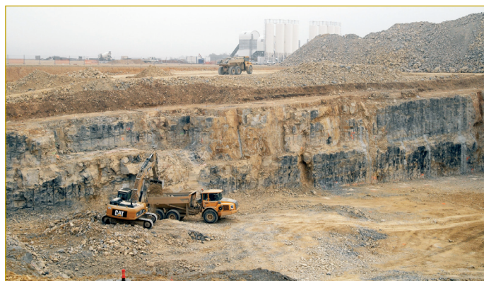
Figura 15. Trabajos de excavación por medios mecánicos. Foto febrero 2011, cortesía F4E.
