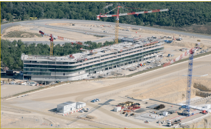
Figura 20. Vista de la nueva sede de IO en construcción. Foto septiembre 2011, cortesía IO.
