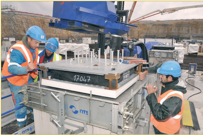
Figura 18. Detalle de un disipador sísmico durante el hormigonado en segunda fase. Fabricados por NTS, los más de 400 soportes requieren un minucioso control de calidad durante su puesta en obra como durante su ejecución. Destacan los conectores soldados a la chapa superior, en espera de ser embebidos en la losa inferior del Tokamak, y diseñados para transmitir las fuerzas de cortante. Foto noviembre 2011, cortesía IO.
