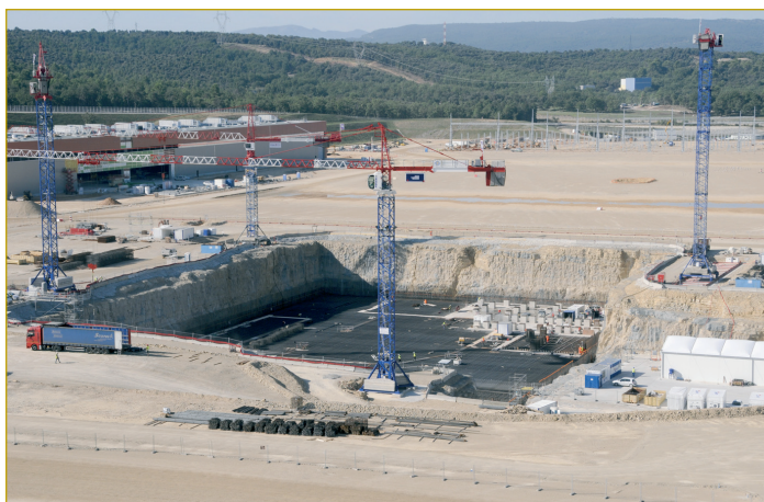
Figura 16. Vista aérea del pozo del Tokamak durante el hormigonado. Aspecto de las tareas de ferrallado y hormigonado de la losa del pozo del Tokamak hacia el verano de 2011. Se observan los primeros soportes de los disipadores a la derecha del pozo. Al fondo el PF coil y la subestación de RTE. Foto septiembre 2011, cortesía IO.
