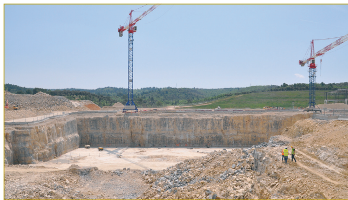
Figura 13. Fondo de excavación del Tokamak del lado de la zona del edificio de celdas calientes. Foto mayo 2011, cortesía IO.
