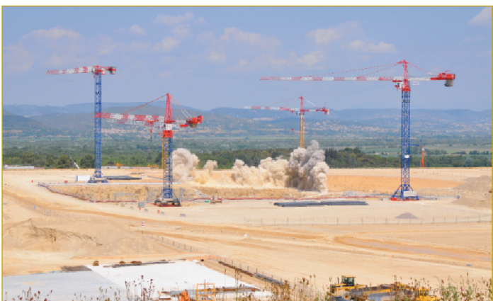
Figura 14. Instantánea de una voladura controlada durante la excavación. Foto mayo 2011, cortesía IO.
