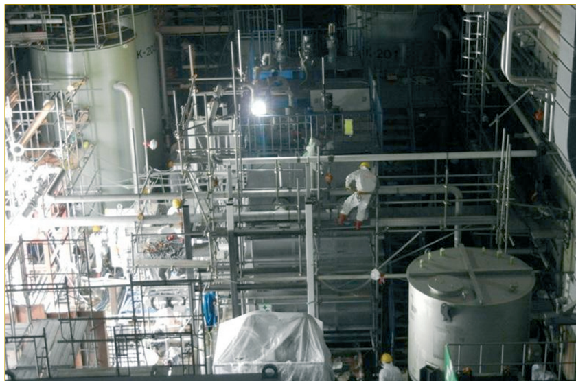
Montaje de la instalación en la planta de Fukushima Dai-ichi. © TEPCO.
