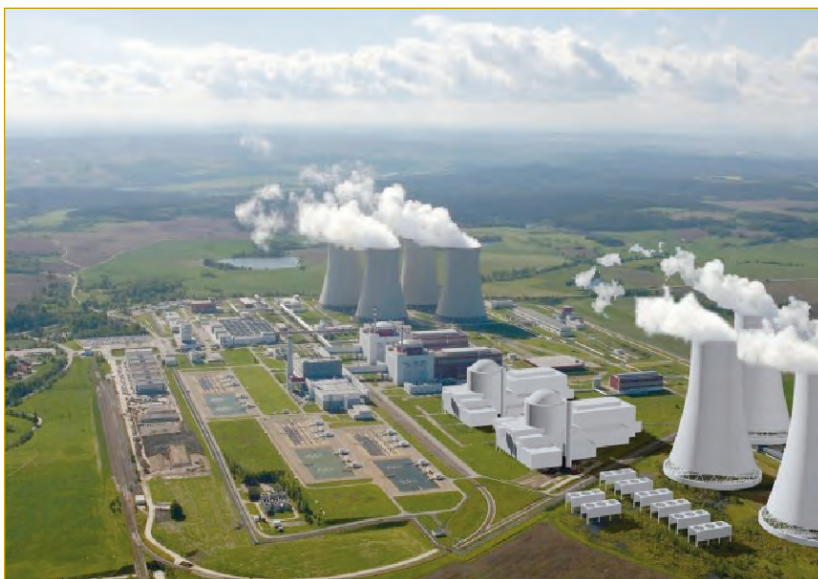
Figura 1. C.N. de Temelin (CEZ, República Checa). En primer término se muestran las futuras nuevas Unidades 3 y 4.
