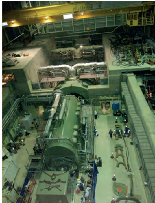
Figura 7. Rehabilitación turbogrupos. Central nuclear Laguna Verde (cortesía CFE).
