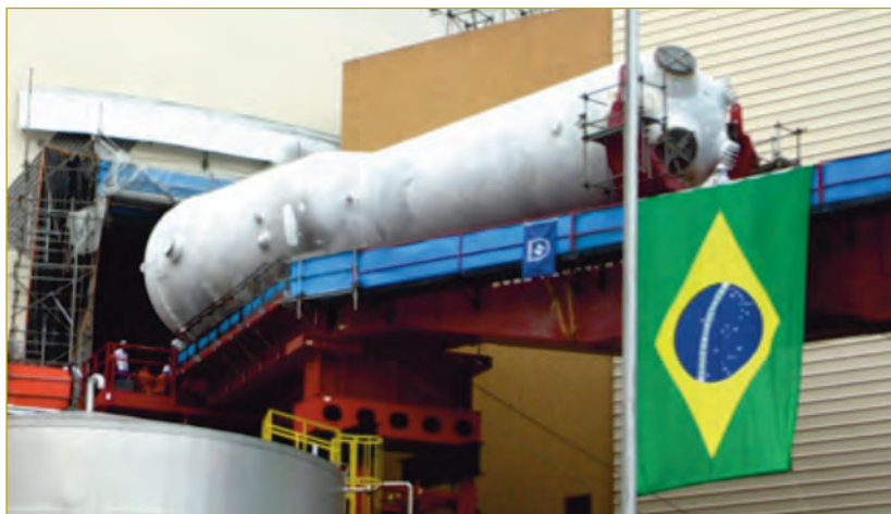
Figura 5. Introducción de un generador de vapor en la central de Angra 1.
