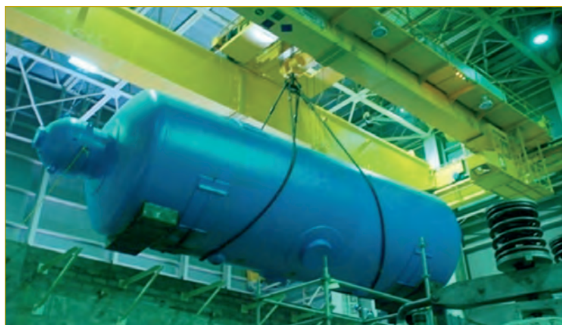
Figura 6. Sustitución MSR central nuclear Laguna Verde (cortesía CFE).
