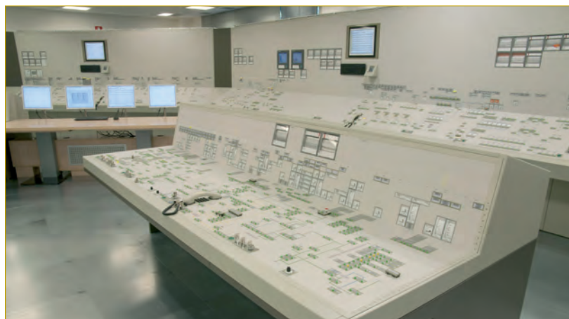
Figura 3: Simulador sala de control Atucha II (Cortesía de CN Atucha II).
