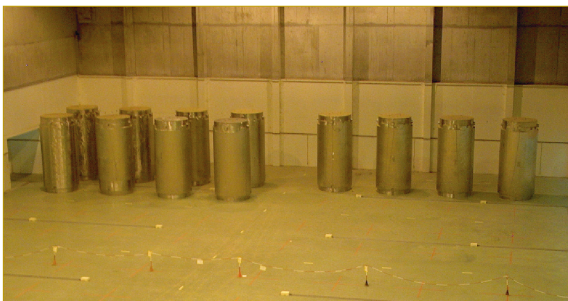
Figura 2. Interior del ATI de Trillo con 12 contenedores (actualmente almacena 22).
