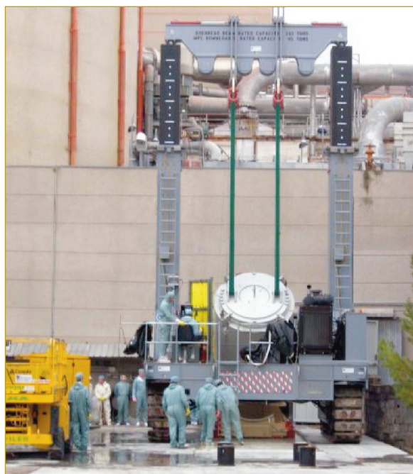
Figura 1. Maniobras de transferencia al ATI del contenedor de Zorita (febrero 2009).
