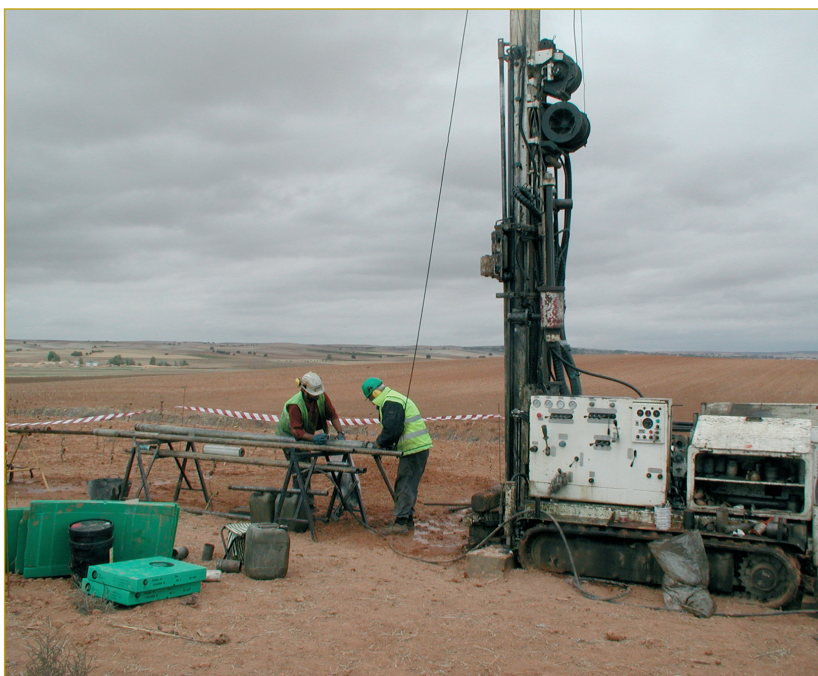
Figura 2. Trabajos de caracterización geológica del emplazamiento del ATC en noviembre de 2012.
