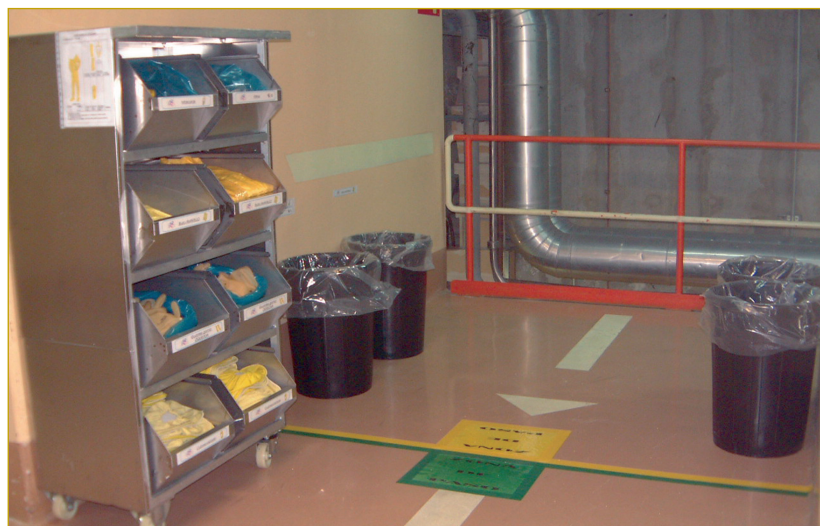
Figura 3: zona de paso en CN Vandellòs II.
