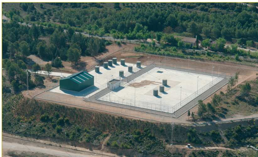
Figura 3. Vista aérea del ATI con parte de los contenedores de residuos nucleares en su posición final.
