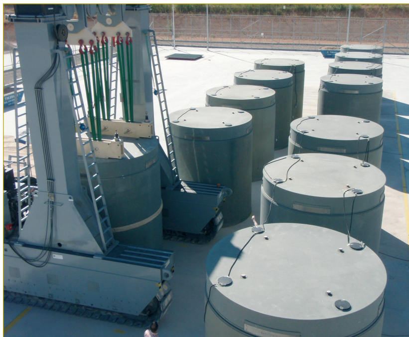
Foto 1. Vista de los contenedores HI - STORM - 100Z y vehículo de transporte.
