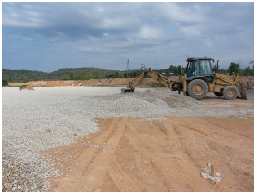
Obras en antiguo vertedero RU.
