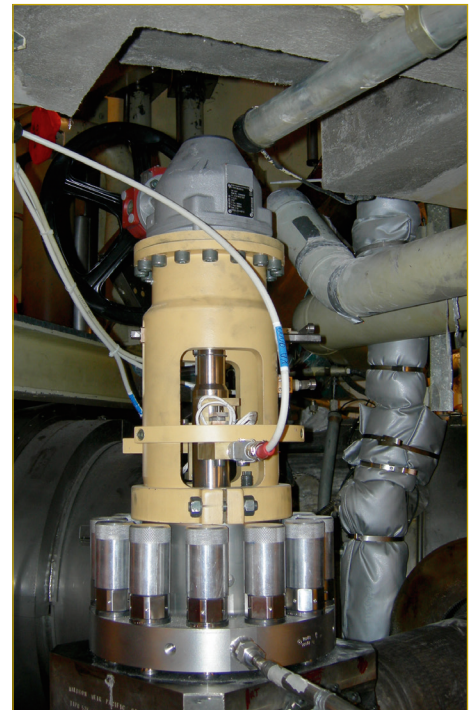
TH Aislamientos manuales 014 S002.
