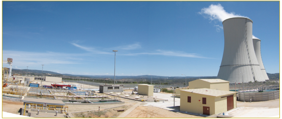
Vistas generales planta pretratamiento.
