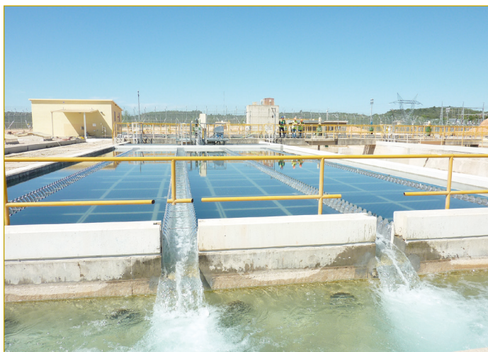
Vista de línea de pretratamiento 1 en 2012.
