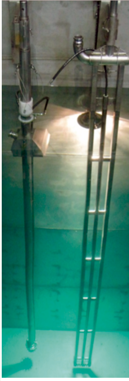
Figura 4. Sistema bomba alta presión (arriba). Pértigas de limpieza interior e exterior de celdas de racks (abajo).
