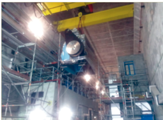
Figura 6. Introducción de la cabeza del filtro de cadenas del tren de salvaguardas 1.
