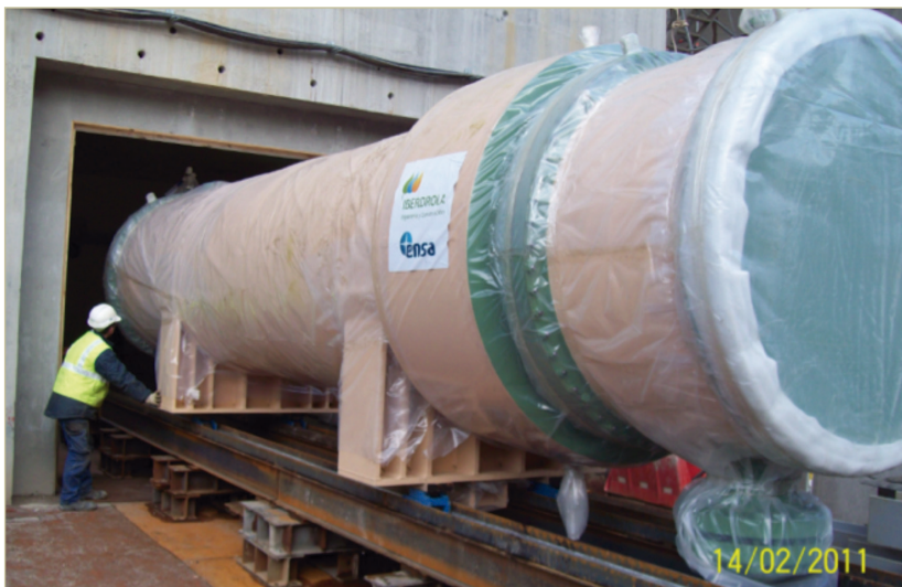
Figura 3. Introducción de los intercambiadores EVU20 en el edificio de Salvaguardias BAS1.
