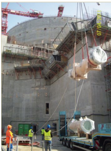
Figura 2. Introducción de los intercambiadores EVU40 en el edificio de Salvaguardias BAS2.
