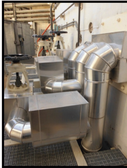
Figura 2. Inyección Alternativa a los Generadores de Vapor para evacuación de calor residual del núcleo.
