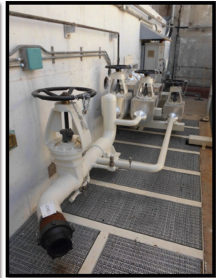
Figura 2. Inyección Alternativa a los Generadores de Vapor para evacuación de calor residual del núcleo.
