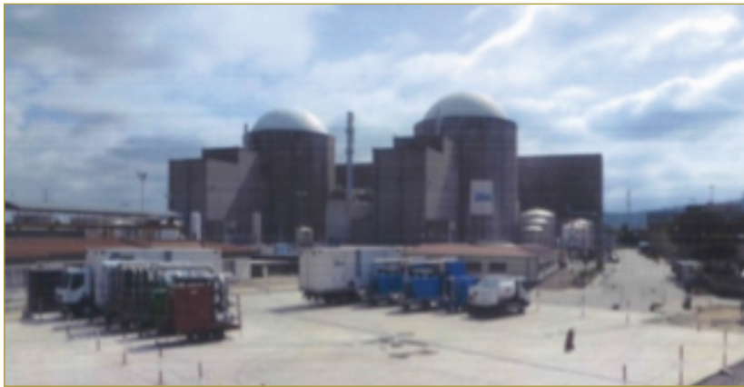
Figura 5. Área de almacenamiento seguro de equipos en CN Almaraz.
