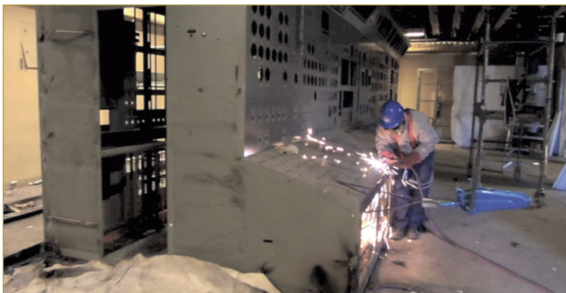
Figura 5. Desmontaje final de la antigua sala de control.
