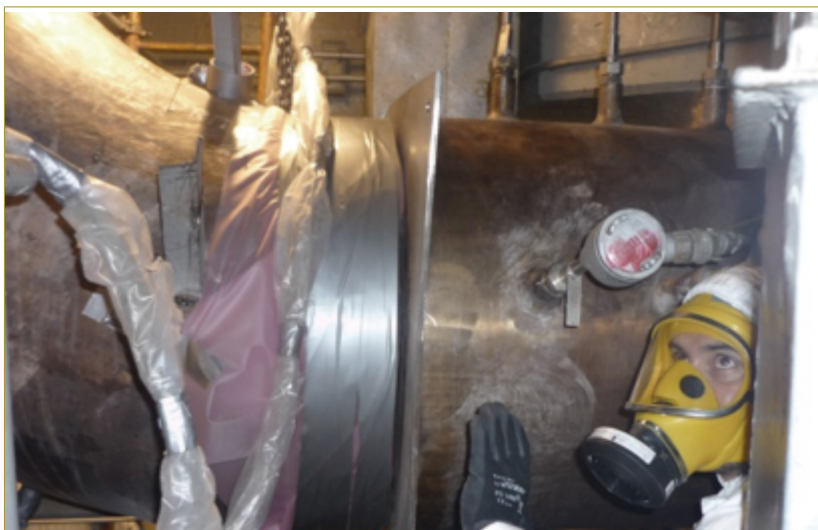
Figura 7. Corte del lazo primario.
