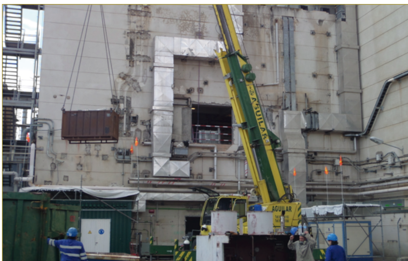
Figura 4. Desmantelamiento de la ventilación del edificio eléctrico.
