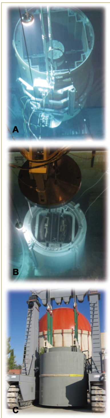
Figura 6. Proceso de corte y acondicionamiento de los internos del reactor. a) corte bajo agua, b) disposición de los cortes en contenedor c) salida del contenedor hacia el ATI.
