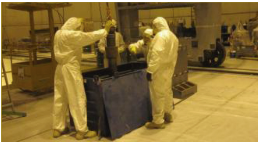
Desmantelamiento de equipos y sistemas.
