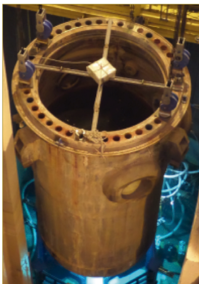
Segmentación y acondicionamiento de la vasija.
