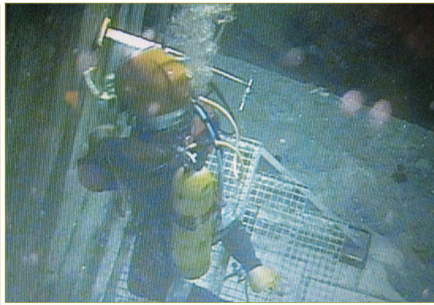
Mantenimiento de estanqueidad de cavidades.
