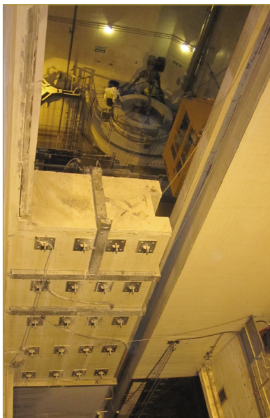
Ampliación del muro de separación entre cavidad y foso de combustible gastado.
