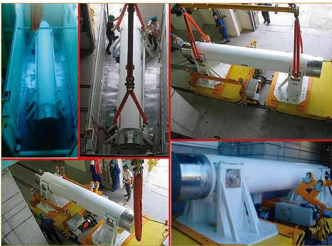
Figura 8. Maniobras de manejo del contenedor a la entrada del Edificio Auxiliar del Desmantelamiento (antiguo Edificio de Turbina).
