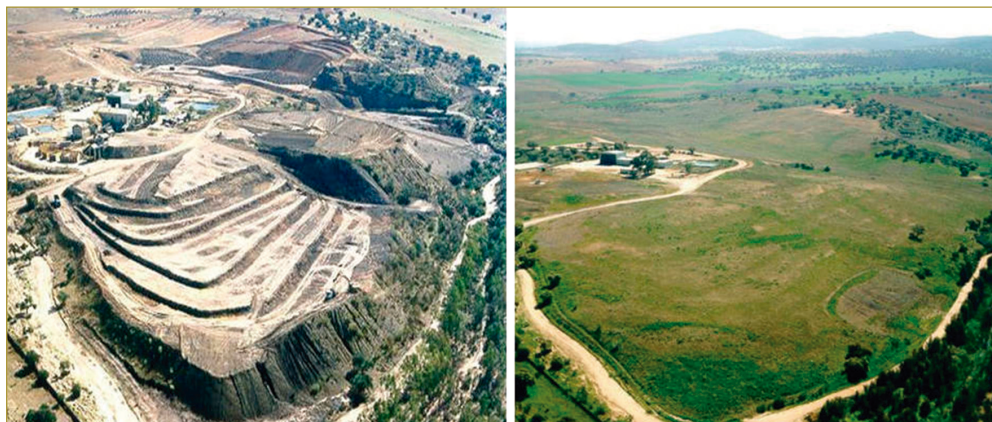
Figura 1. Vista de la corta y escombrera antes y después de su restauración (La Haba).
