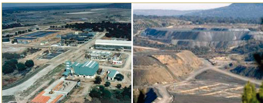
Figura 6. Planta Quercus instalaciones industriales de proceso y era de lixiviación estática (Saelices)
