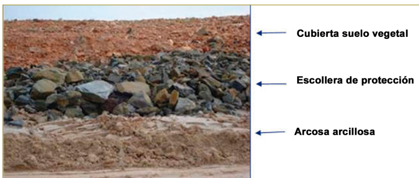
Figura 3. Aspecto y esquema de la multicapa de protección (Saelices).
