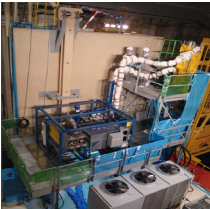
Foto 1. Equipo DCFH montado durante fase de secado de la MPC. Detrás del muro se encuentra el HI-TRAC con la MPC en su interior.
