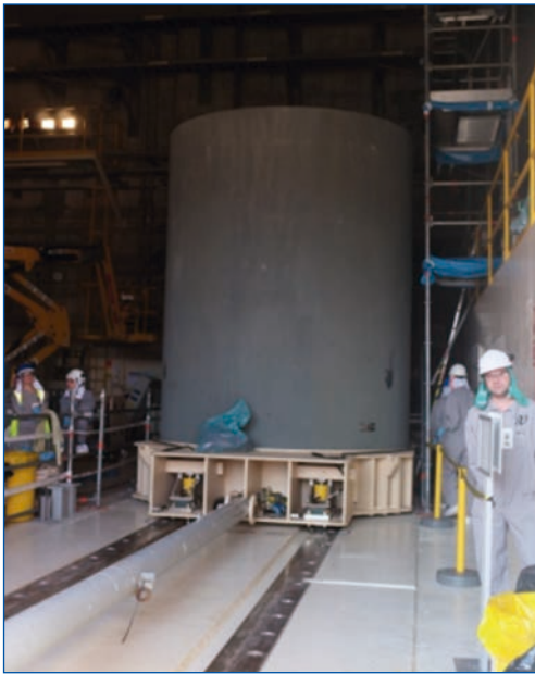
Foto 6. El HI-STORM conteniendo una MPC en su interior está a punto de ser llevado al exterior del edificio de combustible tirando de él con la ayuda de una barra y haciéndolo rodar sobre raíles y subido al ZPT, que es la plataforma de color claro que lo circunda por el extremo inferior.
