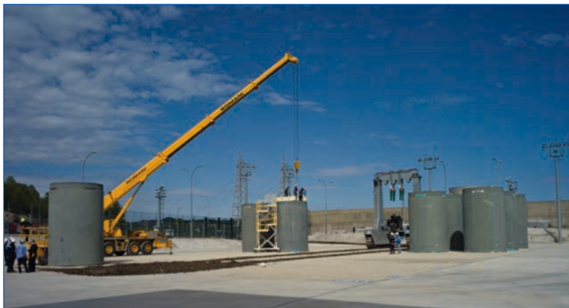
Foto 4. El ATI de C.N. Ascó. El Crawler pasa entre ambas losas para acceder a las posiciones interiores. En este momento se está instalando el dispositivo de izado a un HI-STORM vacío para bajarlo al edificio e iniciar su proceso de carga. El contenedor de la izquierda acaba de llegar lleno desde la Unidad I. Es el primero que se cargó en C.N. Ascó.
