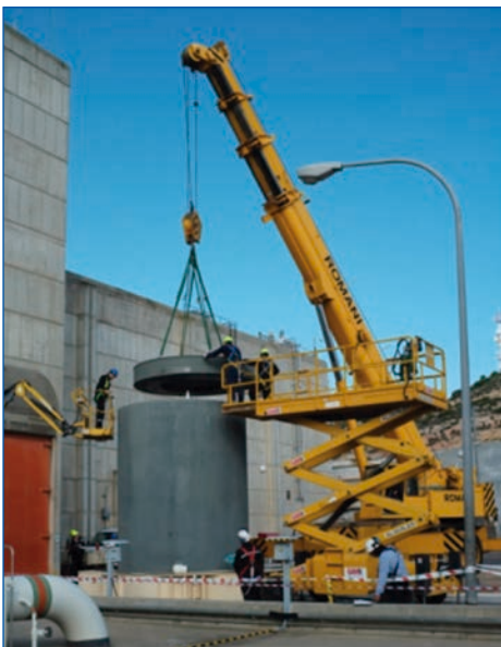
Foto 7. Colocación de la tapa del HI-STORM cuando éste está fuera del edificio de combustible. Para ello se dispone de una grúa auxiliar.
