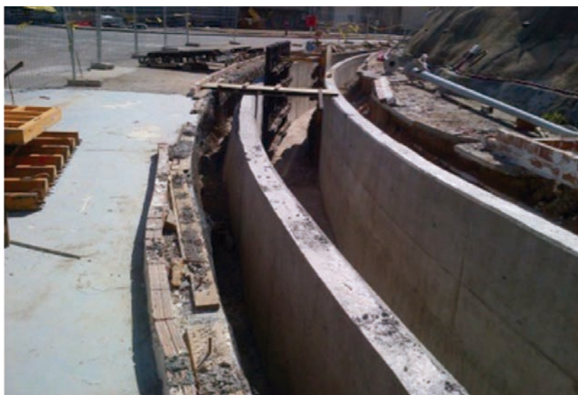
Figura 2. Mejora en la red de drenaje del emplazamiento.
