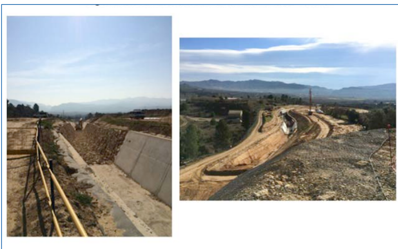
Figura 3. Encauzamiento del barranco de Pochos
