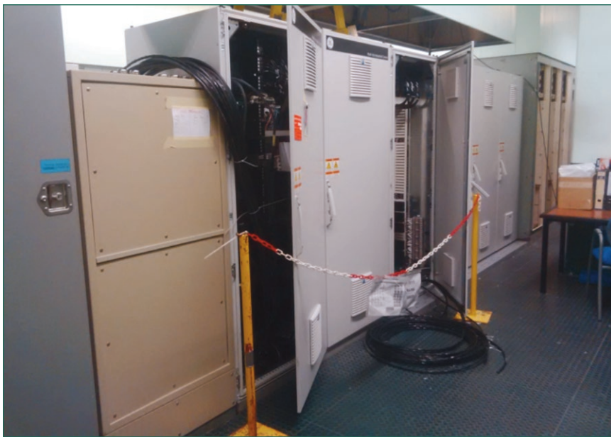
Figura 7. Instalación y cableado de los nuevos paneles en sala de control.
