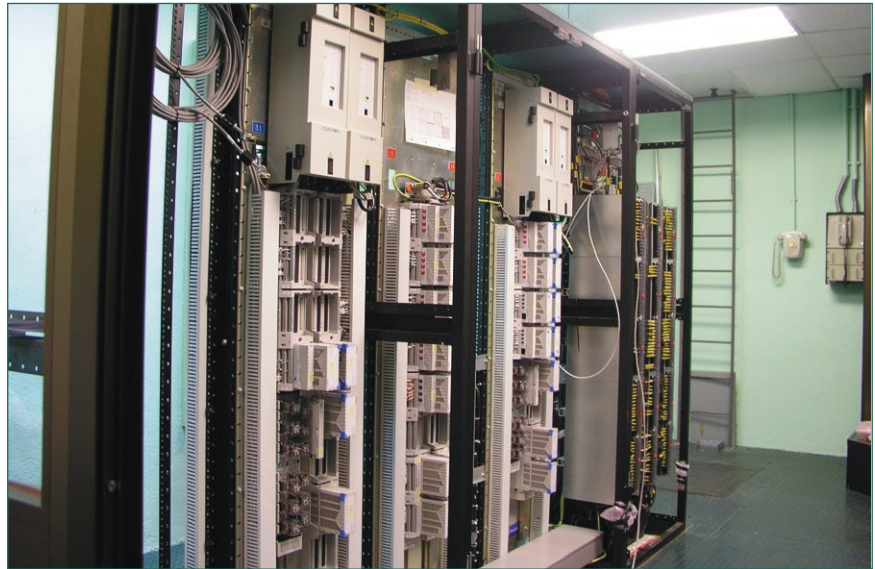
Figura 6. Detalle de Montaje del DEH de Almaraz.
