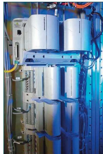
Figura 1. Controladores de proceso redundantes y módulos de entradas/salidas de Ovation .
