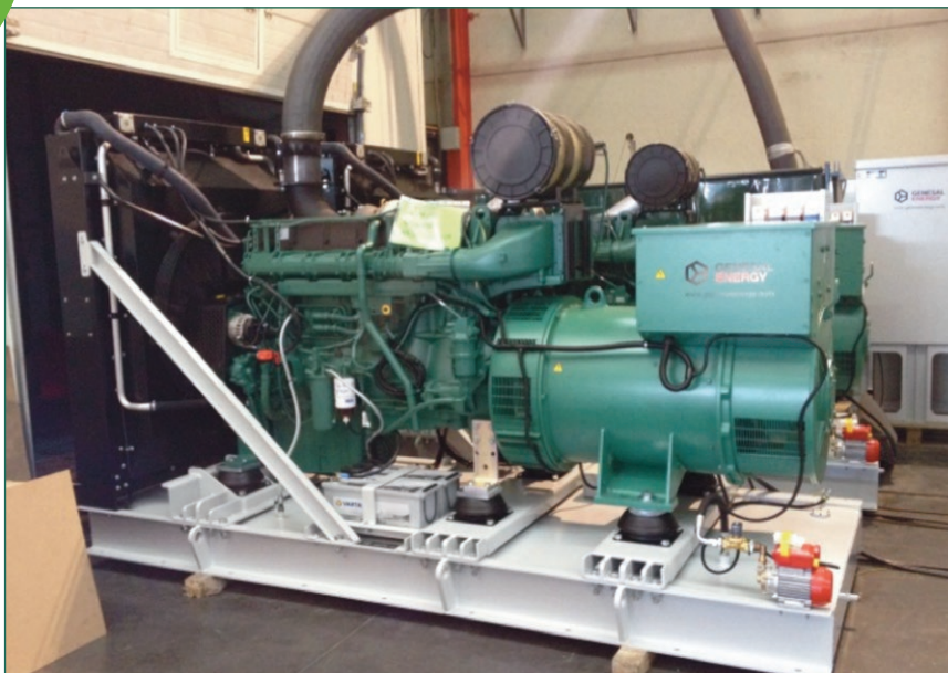
Figura 7. Generador Diésel.
