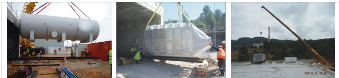
Figura 9. Montaje del tanque de agua potable en CNA y de AFU y Chiller en CNC.
