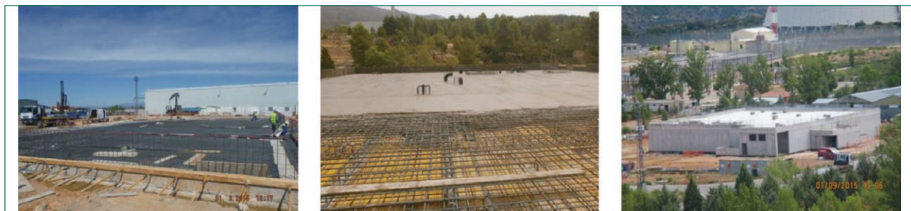
Figura 8. Ejecución de diferentes actividades de obra civil: losa de cimentación (CNA), losa de cubierta (CNC) y vista general del edificio tras la finalización de la obra civil (CNT).
