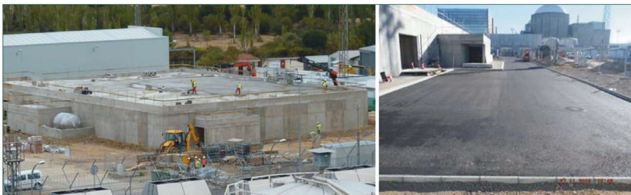
Figura 10. Vista general del CAGE de CNA desde planta, vista del vial del CAGE de CNA.
