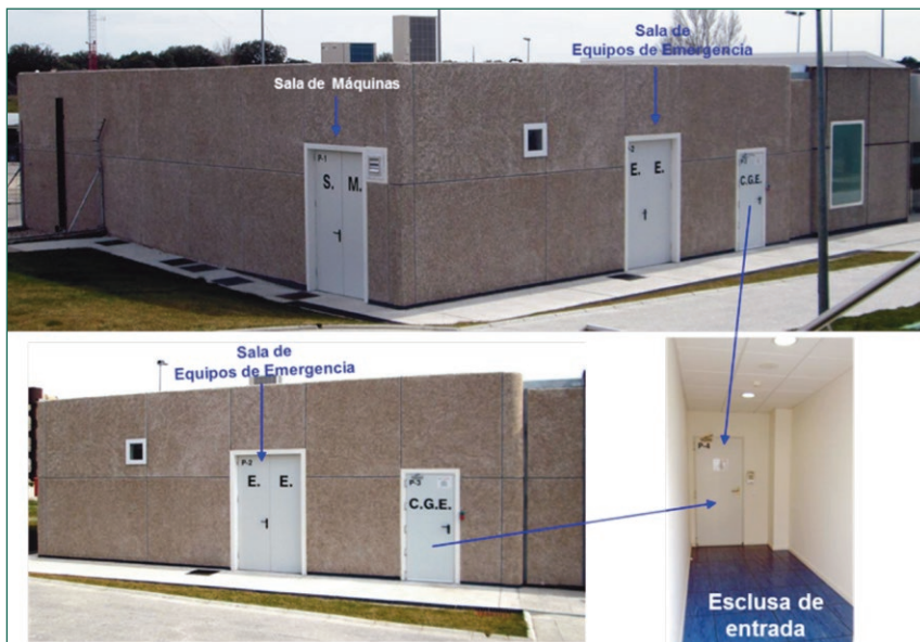
Figura 1. Vista general del Centro de Gestión de Emergencias.
