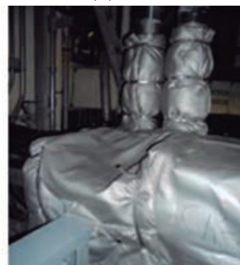
Montaje de barrera de separación sólida en bandejas eléctricas.
