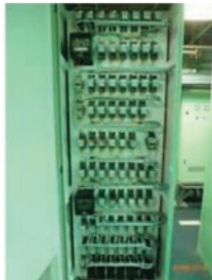
Modificaciones realizadas en cabinas CRA-M y CRA-N.
