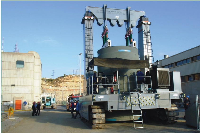
Figura 3. Operaciones con el 'CRAWLER' en el ATI de C.N. Ascó (Fuente, ANAV).
