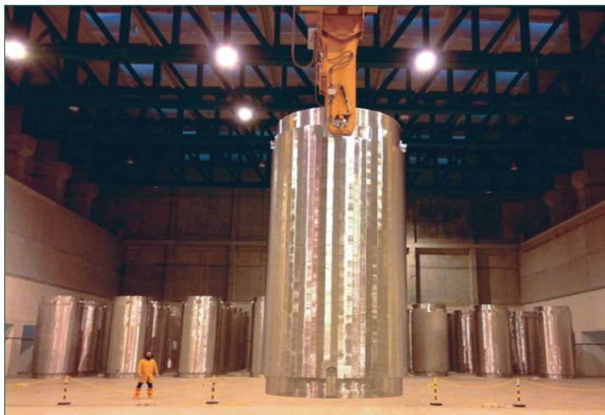
Figura 2. Contenedor ENSA-DPT n°30 en su posicionamiento en el ATI de C.N. Trillo.
